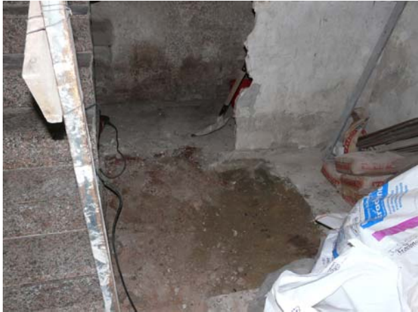
Foto 1. Vista inicial de l'espai on s'havia projectat el fossat d'ascensor
