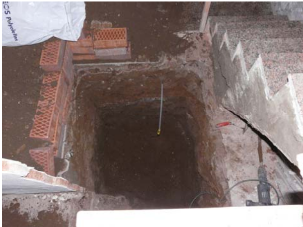
Foto 3. Vista final del fossat d'ascensor. Des del S.
