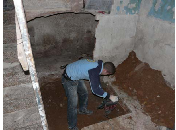
Foto 2. Excavació de forma manual del fossat d'ascensor.
